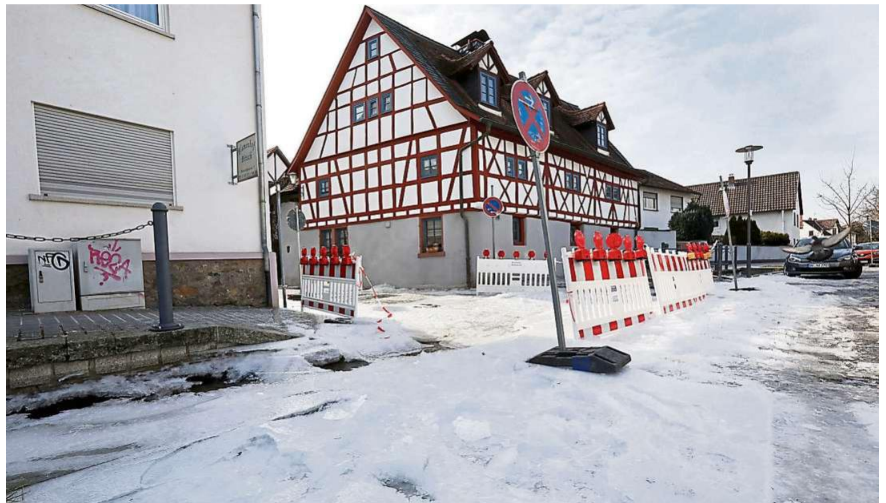
Dicke Eisplatten bedecken die Furt in der Bickenbacher Bachgasse. Das Wasser durfte in diesem Jahr zunächst aus Umweltschutzgründen nicht abgestellt werden. Foto: Torsten Boor
