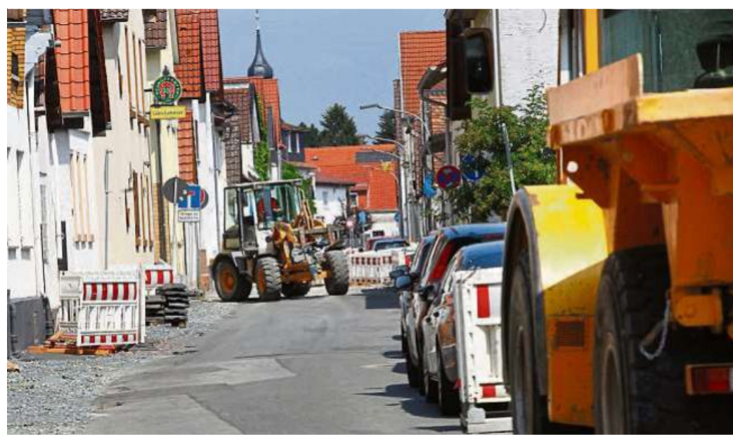
Komplett erneuert wird die Rügnerstraße in Pfungstadt. Im April kommenden Jahres soll der zweite Bauabschnitt abgeschlossen sein. Foto: Karl-Heinz Bärli
